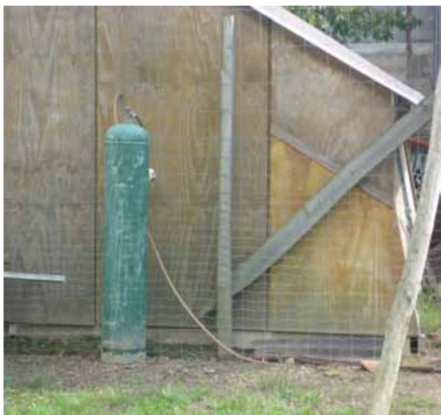
Réserve de gaz pour les radiants placée à l'arrière des cabanes mobiles
