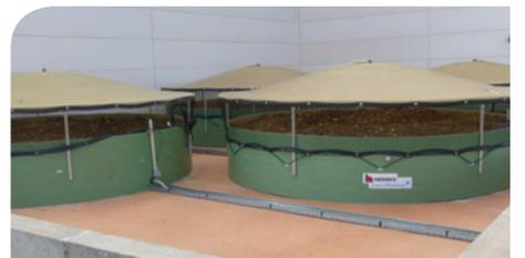
Le Phytobac est un procédé de récupération et de dégradation des effluents phytosanitaires : eau de lavage, de rinçage (pulvérisateurs, tracteurs, bidons, ...), eau accidentelle (local phyto), basé sur le pouvoir épurateur d'un sol reconstitué, actif biologiquement.
